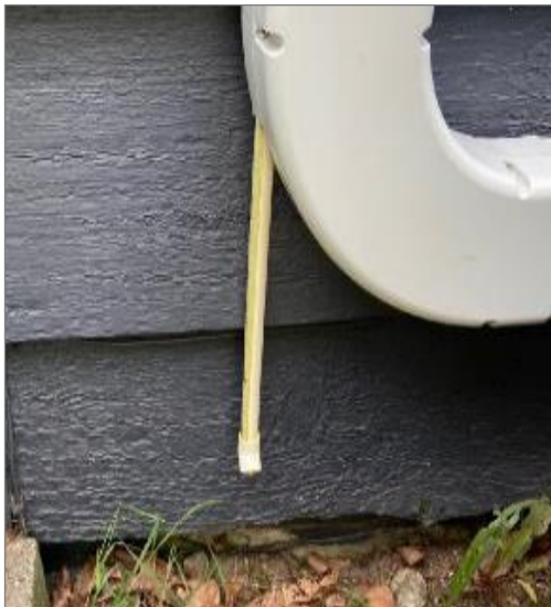
Condensate Drain - OD condensate termination
